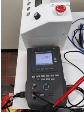
รูปที่ 14 ทดสอบค่าความต้านทานสายกราวด์ (Grounding wire resistance)
